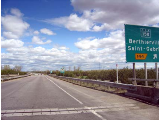
Autoroute 40 EST Sortie 144 Berthierville / St-Gabriel
