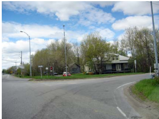
Voici l'intersection pour la 347 NORD.
